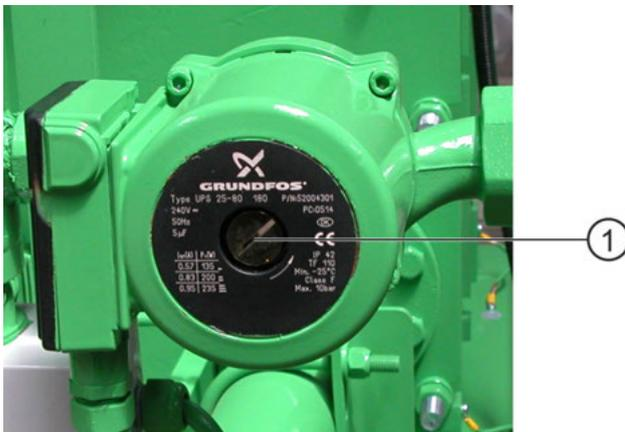
① Vite di sfiato della pompa di preriscaldamento
