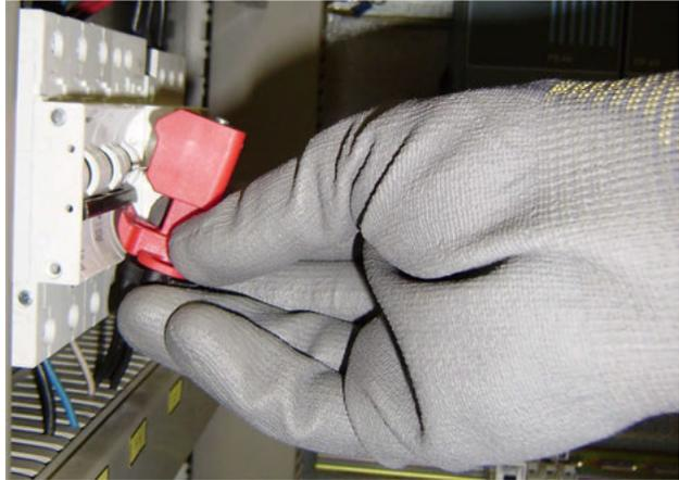
Assicurazione multipla con dispositivo di blocco TB e lucchetto lockout assicurato
