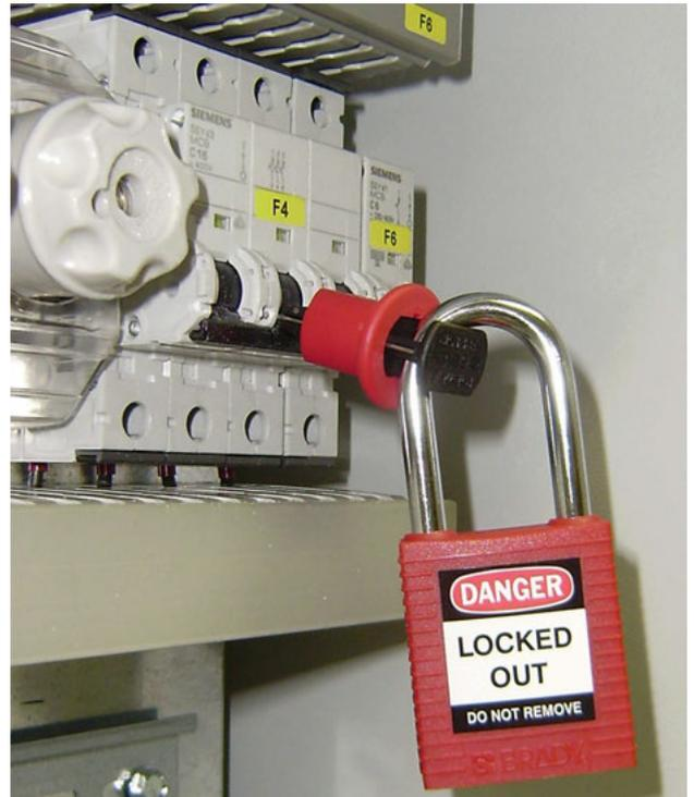
Fusibile singolo bloccato con dispositivo TB, moschettone e più lucchetti lockout, se sull'impianto lavorano più persone.
