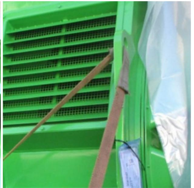
Fig. 25: Dettaglio punto di attacco 2 generatore
