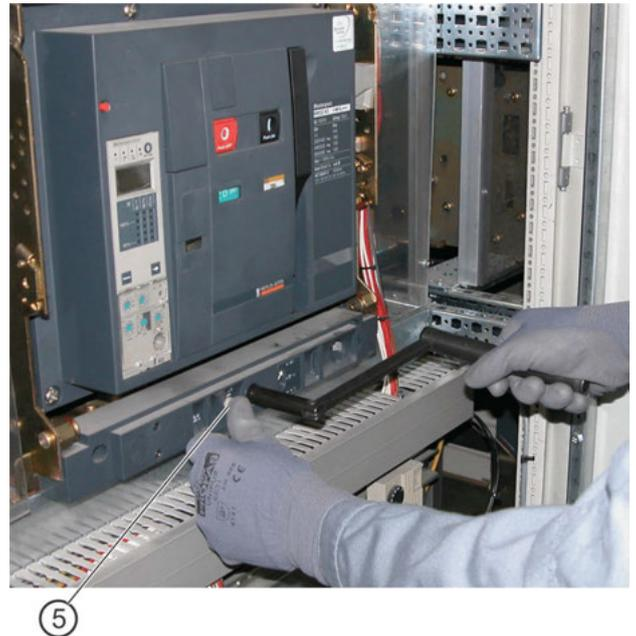
5. Nella posizione Test lo sbloccaggio manovella rientra automaticamente. Premere di nuovo lo sbloccaggio manovella (5) e continuare a ruotare finché la posizione interruttore (3) indica la posizione inferiore "disaccoppiato".
