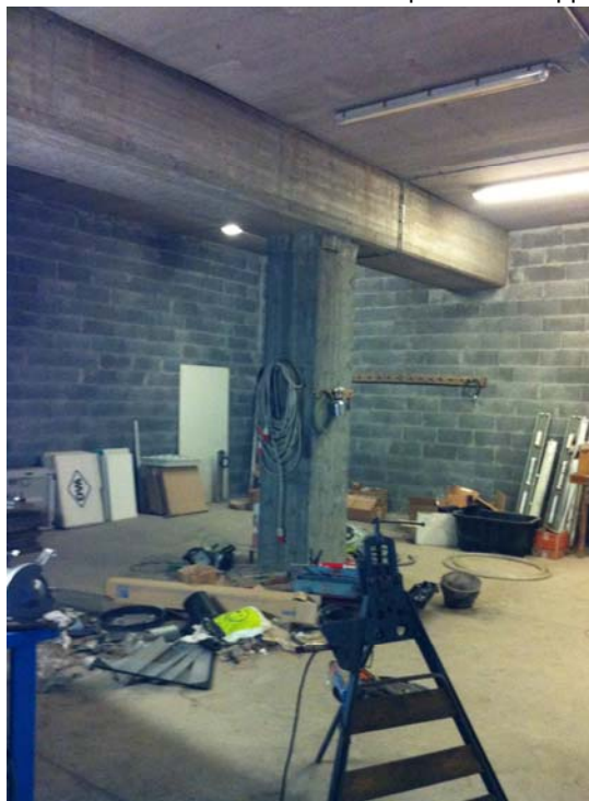
Interno del locale
