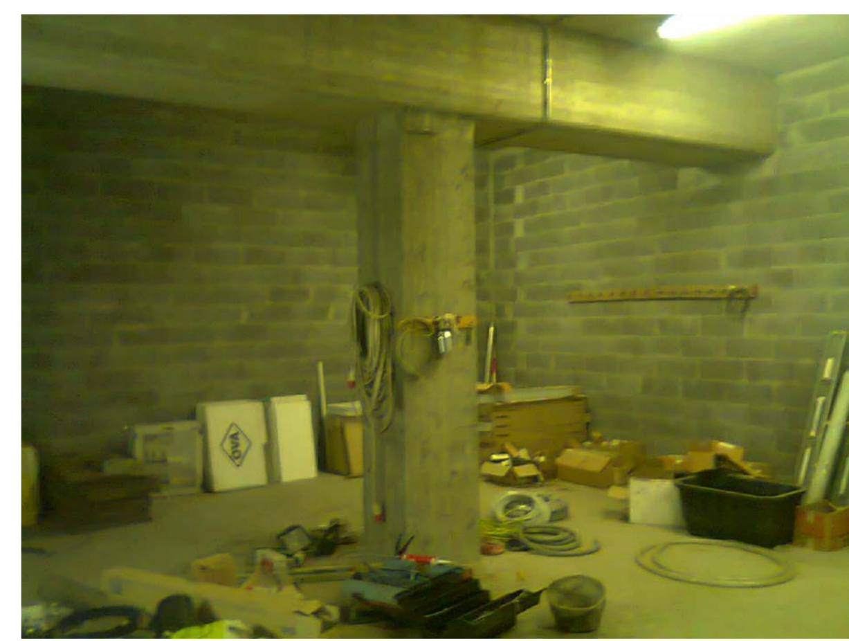
DOCUMENTAZIONE FOTOGRAFICA INTERNI
