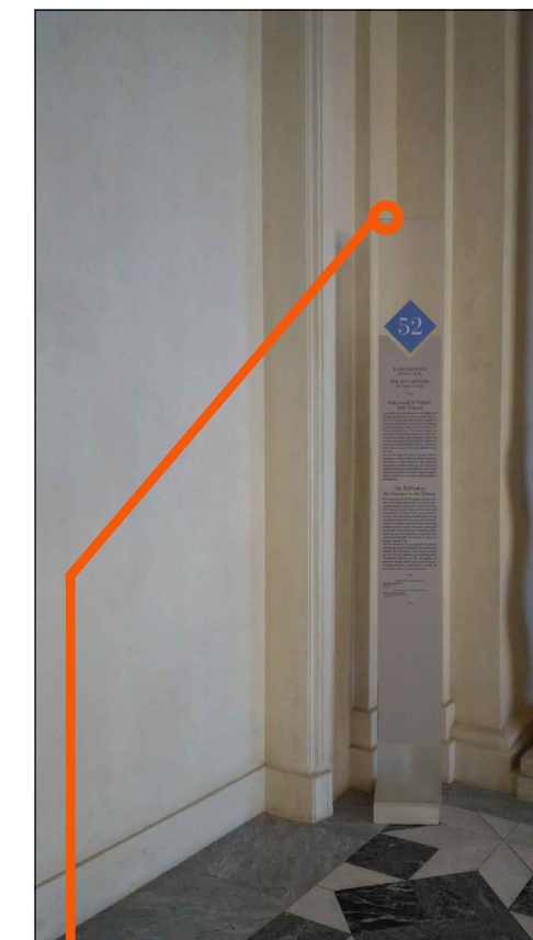
ART 12.29 - Sostituzione palina informativa con ancoraggio al muro mediante profilo Halfen e tasselli chimici.
