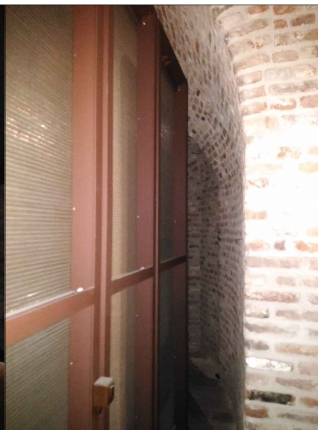
ART 11.02 - LATO 2 - vista del retro dei telai metallici
