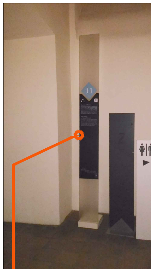
ART 12.10 - Sostituzione palina informativa con ancoraggio al muro mediante profilo Halfen e tasselli chimici
