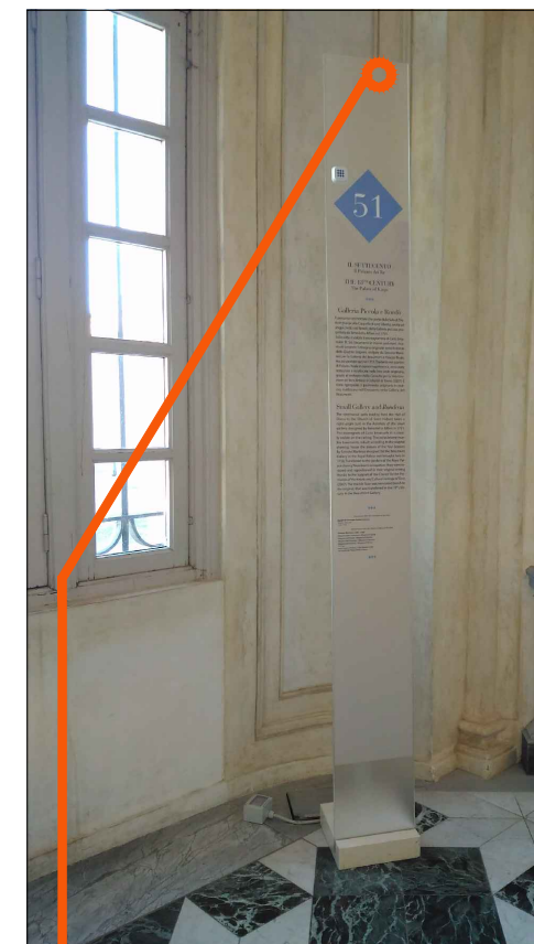
ART 12.28 - Sostituzione palina informativa con ancoraggio al muro mediante profilo Halfen e tasselli chimici.
