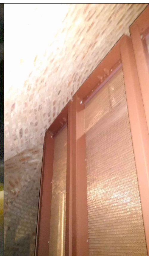
ART 11.04 - LATO 4 - vista del retro dei telai metallici
