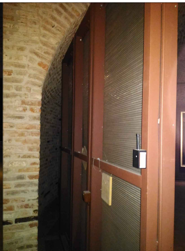
ART 11.01 - LATO 1 - vista del retro dei telai metallici
