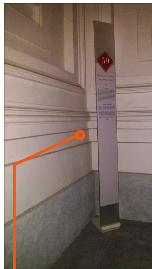
ART 12.32 - Sostituzione palina informativa con ancoraggio al muro mediante profilo Halfen e tasselli chimici
