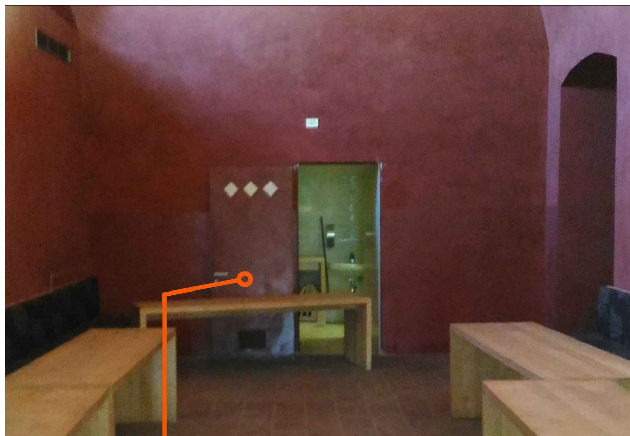
ART 9.12 - Ripristino porta esistente con cambio cerniere 90x210(H) cm
