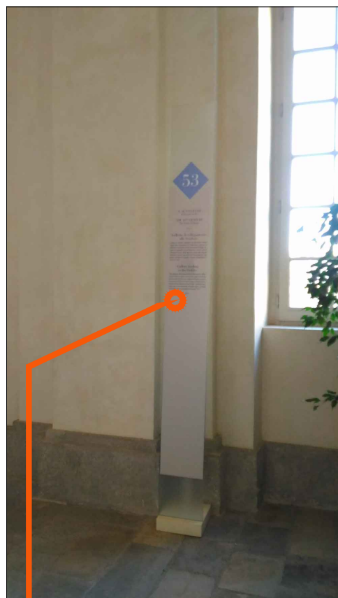
ART 12.30 - Sostituzione palina informativa con ancoraggio al muro mediante profilo Halfen e tasselli chimici
