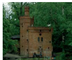
> Stazione di pompaggio
